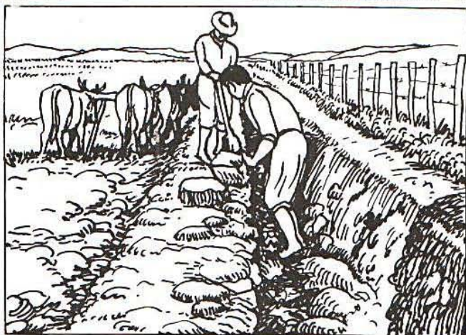
Des. 3. Construção de um canal de irrigação em torrões (Rio Pardo).
