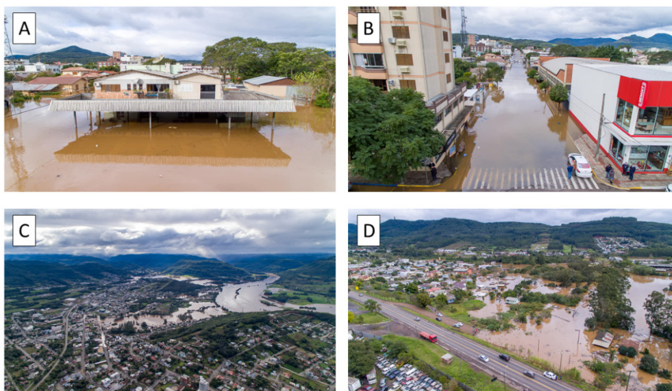
Figura 1 – Apresenta alguns pontos inundados, como: a) Rodoviária de Encantado, b) Rua Sete de Setembro – Centro, c) Bairro Vila moça, d) Bairro São José na RS-129.
