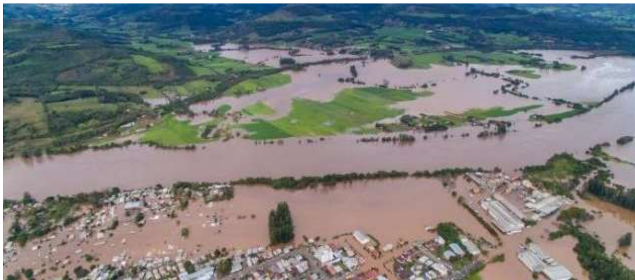
Figura 3 - Cenário da inundação de 2020 na cidade de Encantado, mostrando o canal principal do rio Taquari e o alcance das águas na cidade e nas áreas rurais de Roca Sales.
