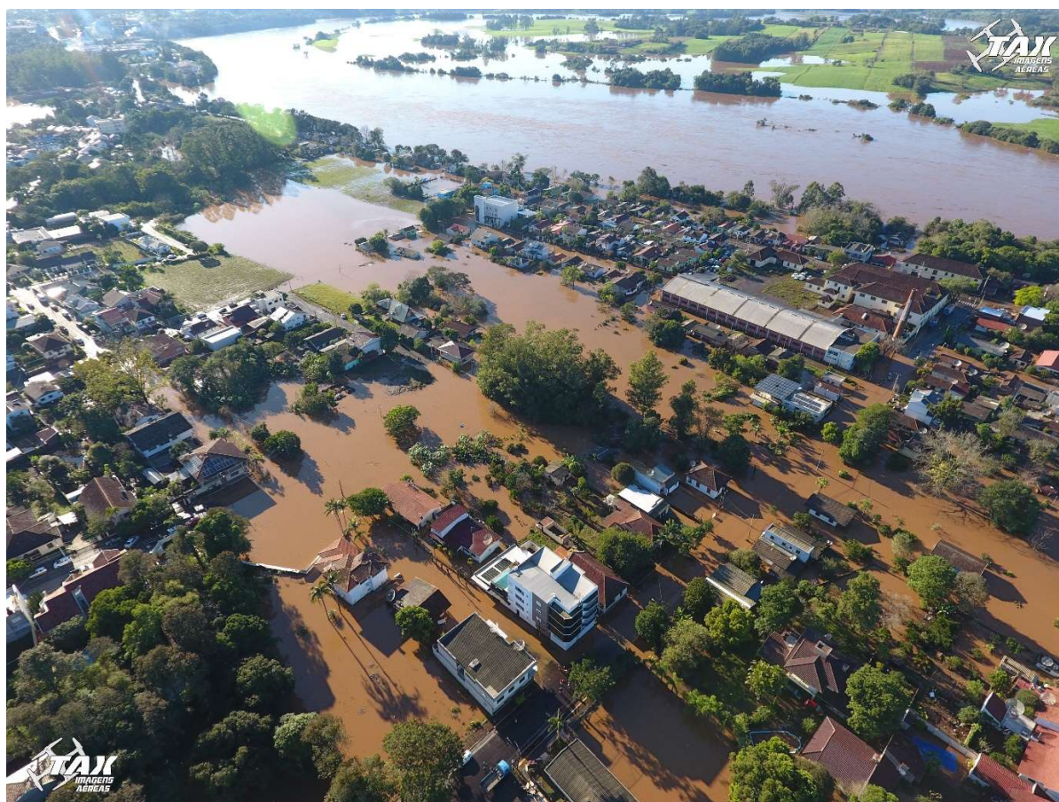
Figura 4 - Registro aéreo da inundação de julho de 2020 na cidade de Arroio do Meio.
