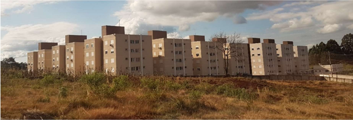
Figura 4 - Vista do empreendimento a partir da Rua Oscar Vieira
