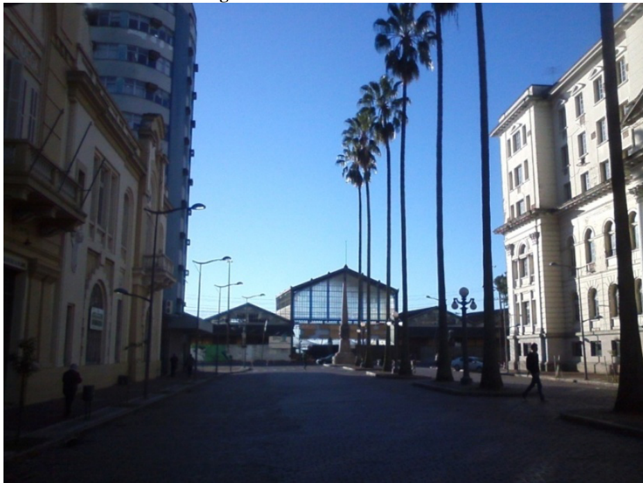
Figura 3 - Pórtico do Cais Mauá
